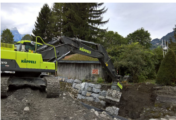
Ersatz einer Ufersicherung
