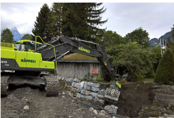
Ersatz einer Ufersicherung
