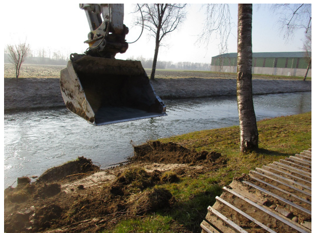
Entfernung von Böschungswülsten
