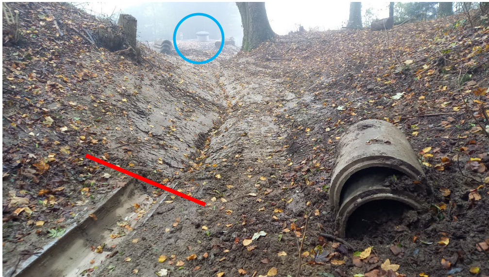
Foto 13: Sandloch mit Bachgerinne, im Vordergrund mit einbetonierten Halbschalen. Talseits wurde 2024 die Brunnenleitung erneuert und mit einer Lehmadichtung überdeckt. Es ist geplant, die verbleibenden Halbschalen als Schutz für die Quellen wieder einzubauen (ohne zusätzlichen Beton). Im Hintergrund (○) die 2024 neu erstellte Brunnenstube.
