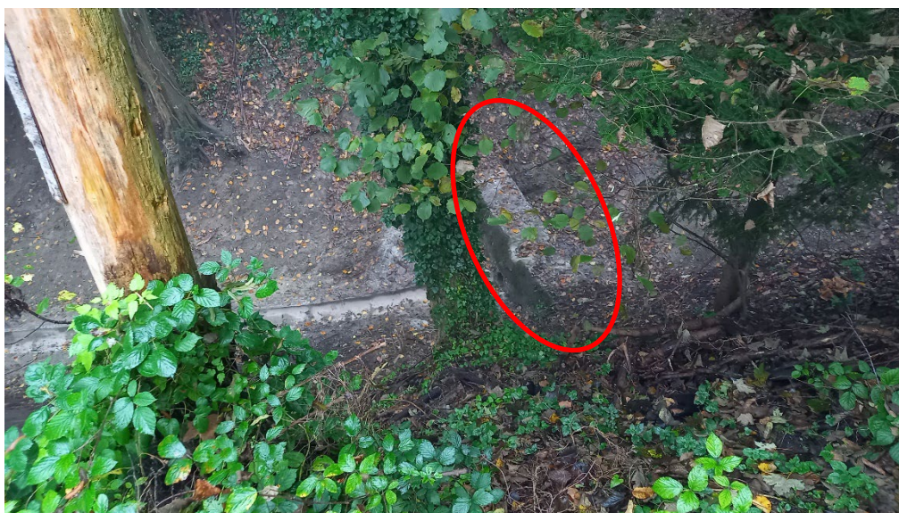
Foto 10: Blick vom Holzlagerplatz ins Sandloch. Die Quelfassungen liegen unter der Gerinne- sohle, links der Betonmauer (= Kiesfang ○ ).
