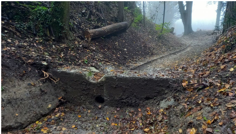
Foto 12: Sandloch, Blickrichtung abwärts zur Brunnenstube. Im Vordergrund Kiesfang hinter Betonmauer, hinter der Mauer Bachgerinne mit Betonhalbschalen. Die Sandlochquellen liegen unter dem Gerinne.
