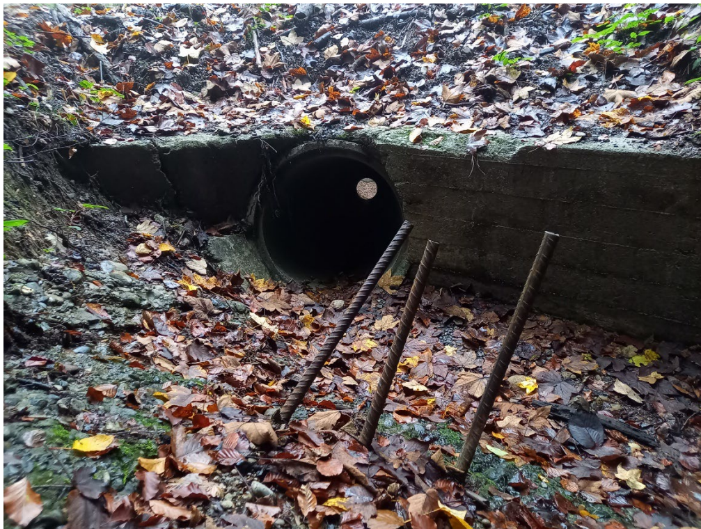
Foto 2: Einlaufbauwerk und Durchlass (80cm) unter der Wolkenbergstrasse zum Sandloch hin. Der einfache Geschieberechen soll im Rahmen des HWS-Projekts ersetzt werden.
