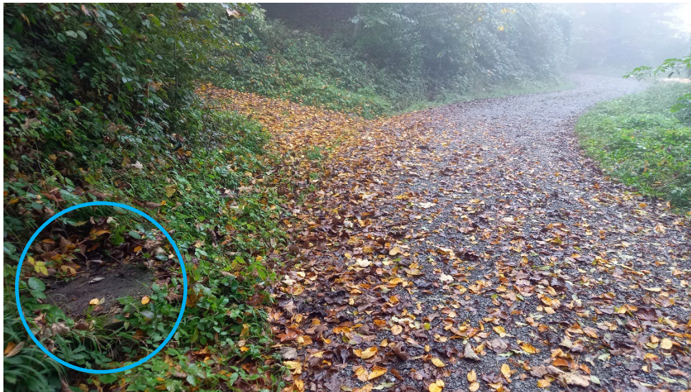
Foto 5: Wolkenbergstrasse mit erstem Einlaufschacht am unteren Ende der Rigole, vor der Einmündung eines Waldweges.
