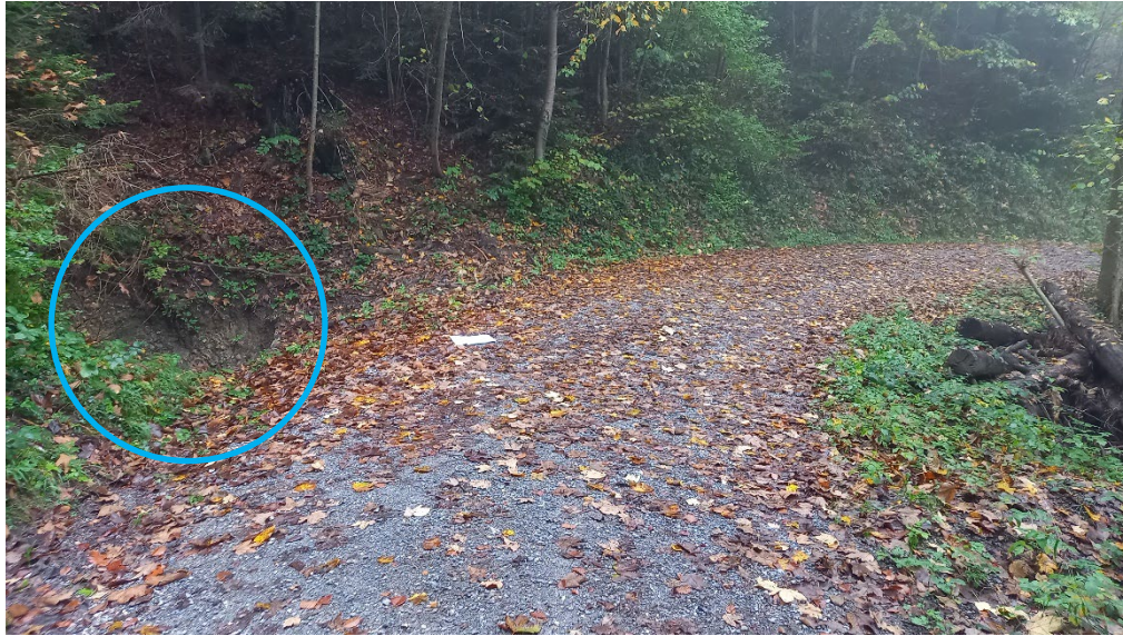
Foto 3: Wolkenbergstrasse, links Bachgerinne mit Einlaufbauwerk und Durchlass, rechts ausserhalb des Bildes Böschung zum Sandloch. Bei Hochwasserereignissen ( > HQ_{10} ) mit Verklausungen fliesst ein Teil des Wassers in einer Rigole am linken, hangseitigen Strassenrand ab.
