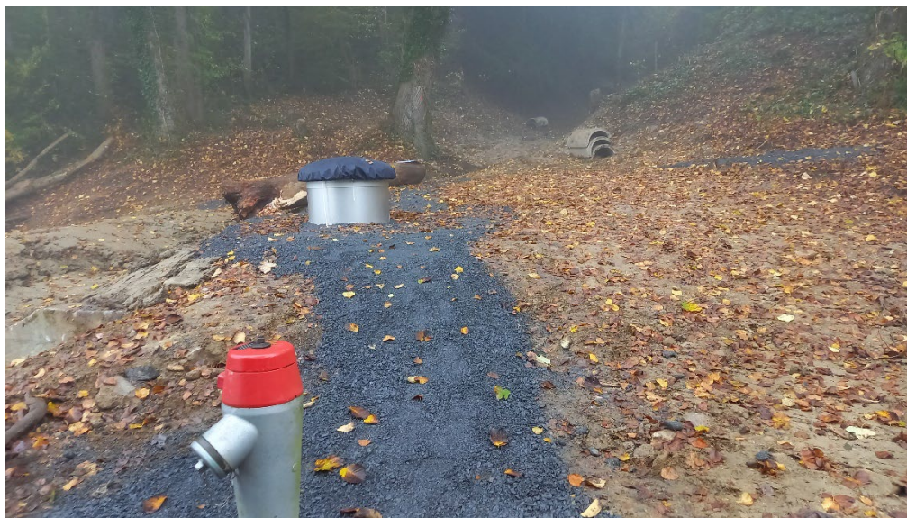
Foto 14: Neue Brunnenstube Sandloch (erstellt 2024), im Hintergrund das Bachgerinne mit den darunterliegenden Quellen.
