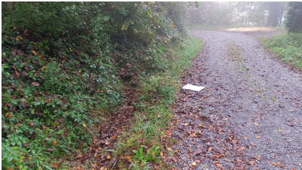
Foto 6: Wolkenbergstrasse mit zweitem Einlaufschacht. Die weitere Ableitung (dm ca. 25 cm) führt unter der Strasse steil nach rechts hinunter ins Sandloch. Im HWS-Projekt soll an dieser Stelle zur Kapazitätserhöhung ein Bodengitter (Weidegitter) mit offener Ableitung in die Böschung zum Sandloch erstellt werden.
