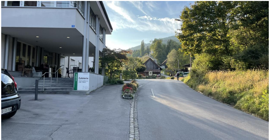
Abbildung 5: Grünensteinstrasse Abschnitt West, mit Trottoir
