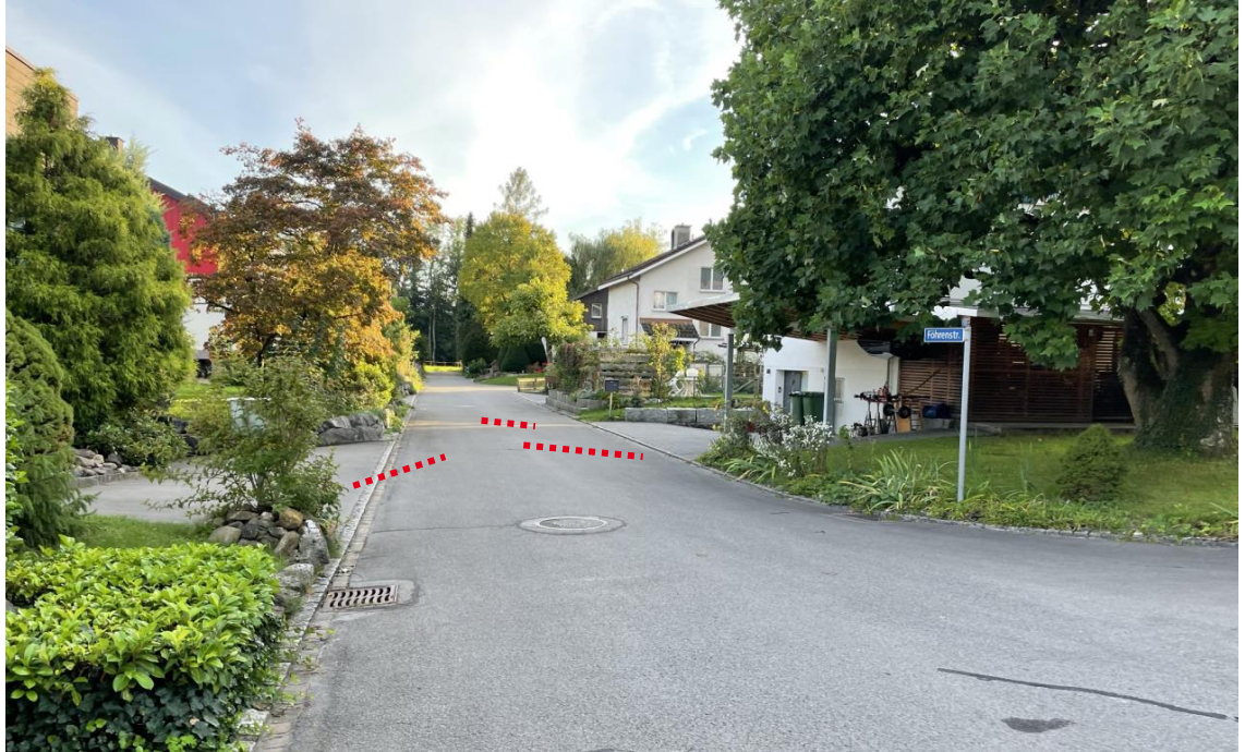
Abbildung 7: Föhrenstrasse, Vorplätze mit eingeschränkten Sichtweiten
