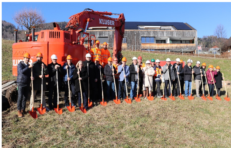
Der erste Spatenstich am 2. Februar 2026 markiert den Baubeginn für das neue Alters- und Pflegezentrum in Balgach.
