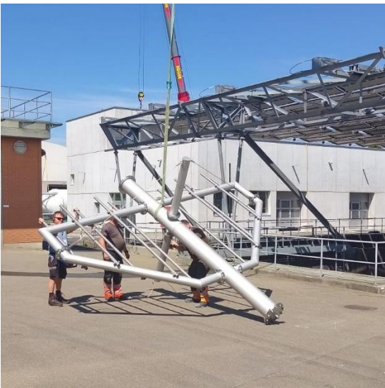
Einbau neues Krählwerk im Einlauftrichter Vorklärbecken 2
