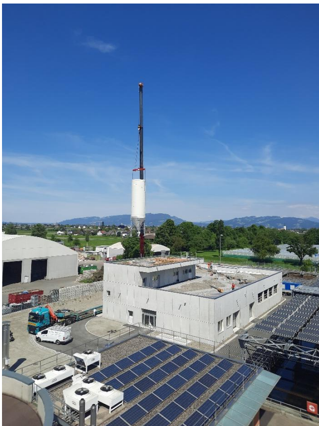
Anlieferung und Aufstellen des Aktivkohle-Silos im Neubau der EMV-Stufe
