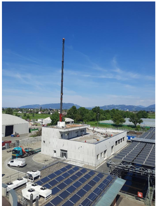
Anlieferung und Aufstellen des Aktivkohle-Silos im Neubau der EMV-Stufe
