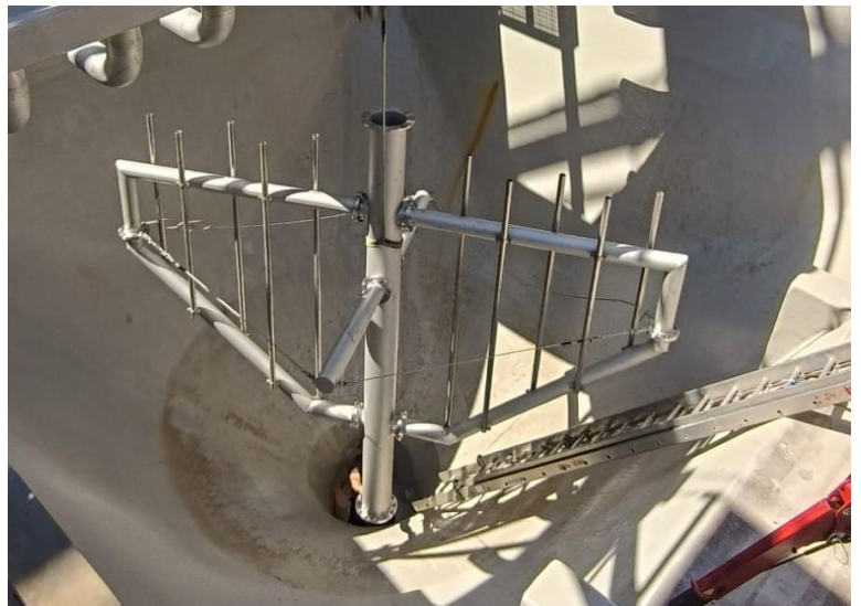
Einbau neues Krählwerk im Einlauftrichter Vorklärbecken 2
