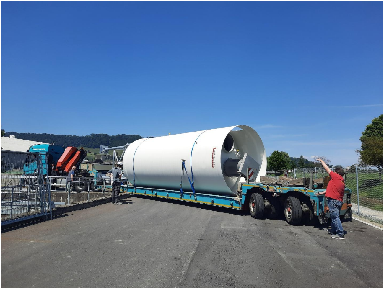
Anlieferung und Aufstellen des Aktivkohle-Silos im Neubau der EMV-Stufe
