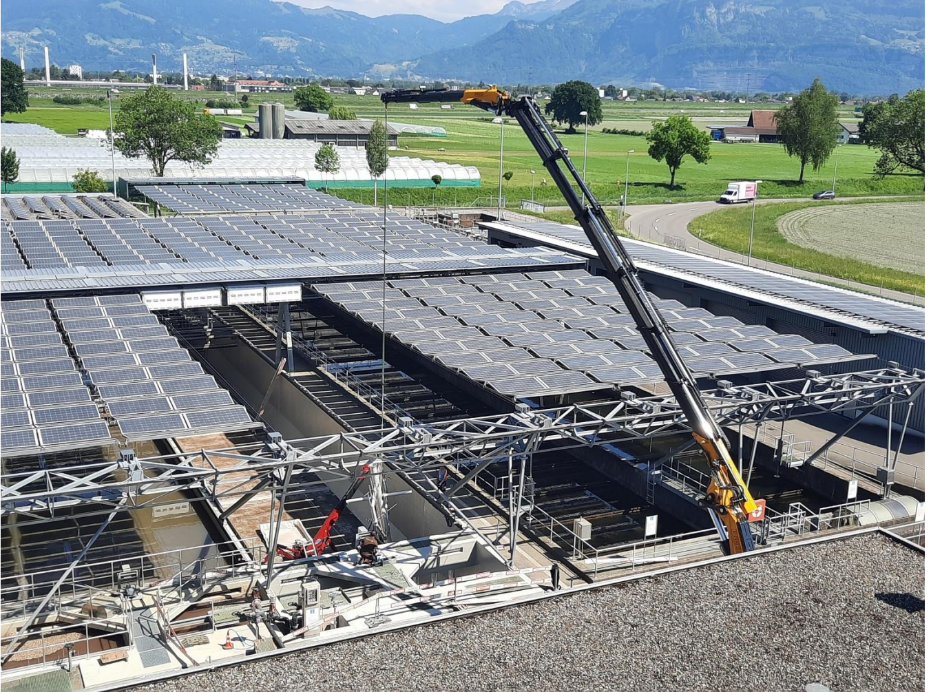
Einbau neues Krählwerk im Einlauftrichter Vorklärbecken 2
